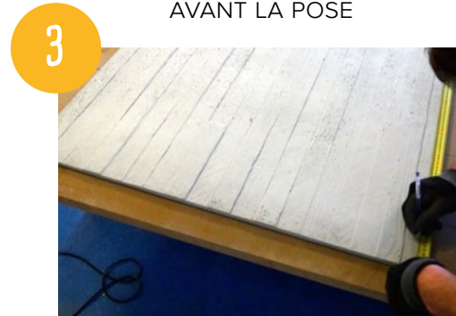
APPLIQUER LES MESURES SUR LE PANNEAU
