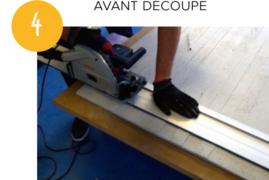
DÉCOUPER À L'AIDE D'UN RAIL DE GUIDAGE
