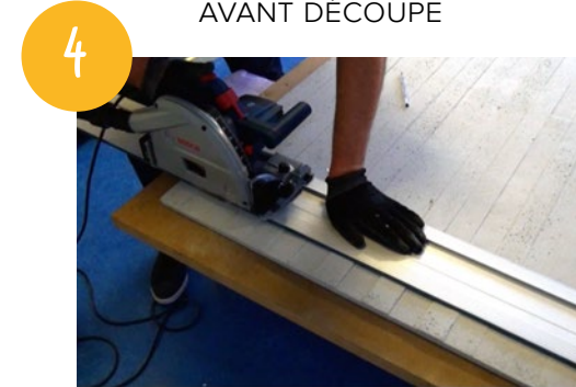
DÉCOUPER À L'AIDE D'UN RAIL DE GUIDAGE
