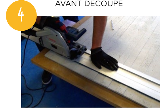
DÉCOUPER À L'AIDE D'UN RAIL DE GUIDAGE
