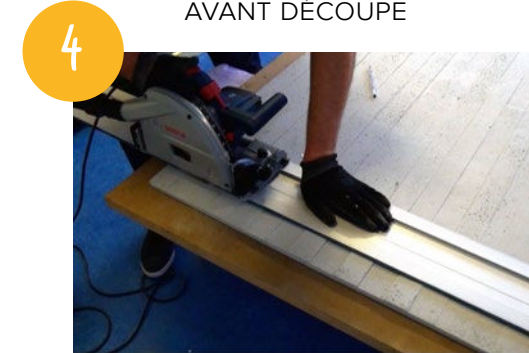
DÉCOUPER À L'AIDE D'UN RAIL DE GUIDAGE
