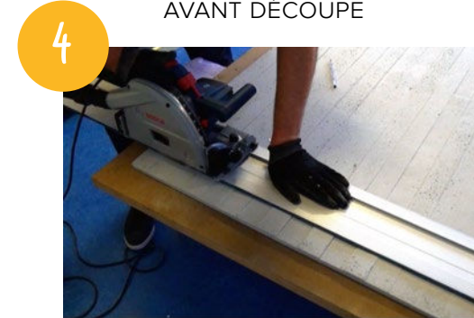
DÉCOUPER À L'AIDE D'UN RAIL DE GUIDAGE
