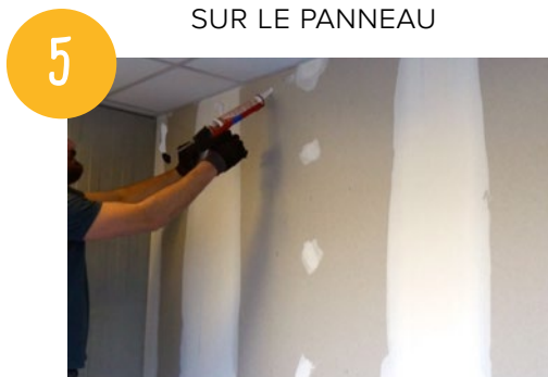
APPLIQUER LA COLLE AU MUR (OU AU DOS DU PANNEAU)
