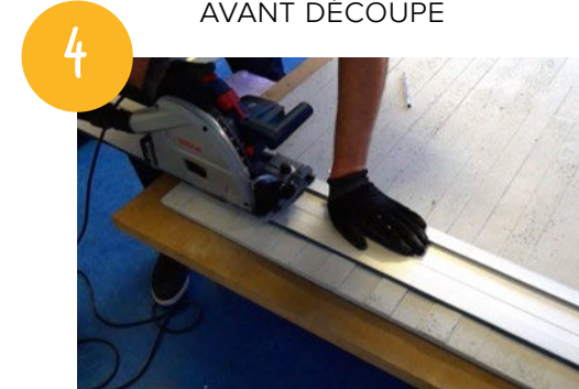
DÉCOUPER À L'AIDE D'UN RAIL DE GUIDAGE
